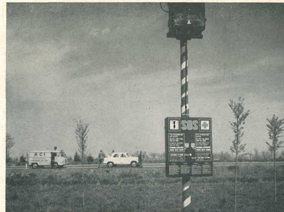
Il carro attrezzi è giunto sul luogo da cui è partita la richiesta di soccorso al capomaglia. Paletti segnalimita, con freccia, alla cui base è scritta la parola « avanti » o « indietro » indicano all'utente il percorso più breve per raggiungere un posto di chiamata S.O.S.
